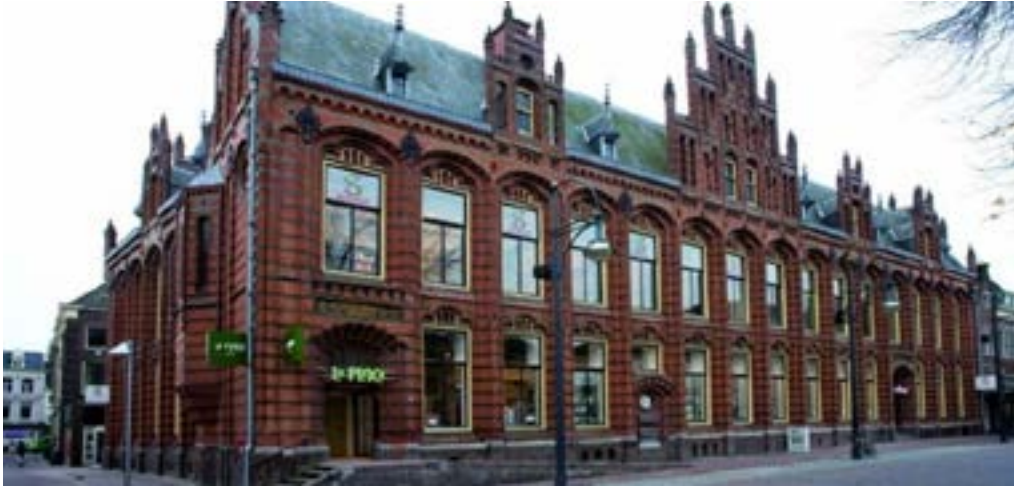
Transformatie voormalig Postkantoor Arnhem
