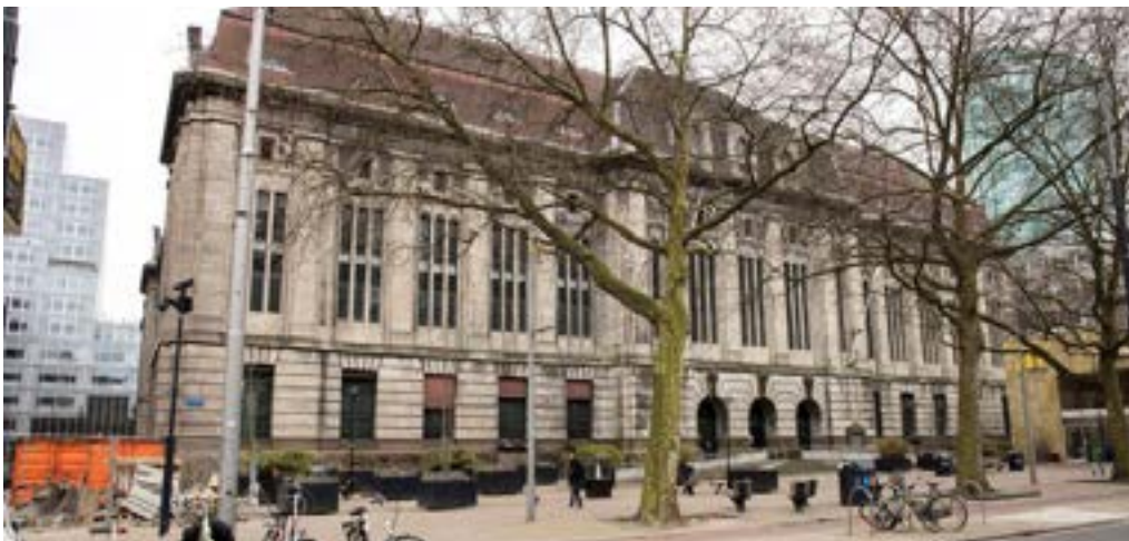
Transformatie voormalig postkantoor Rotterdam
